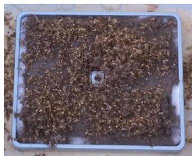
Figure #16 : Filtre à air à remplacer
